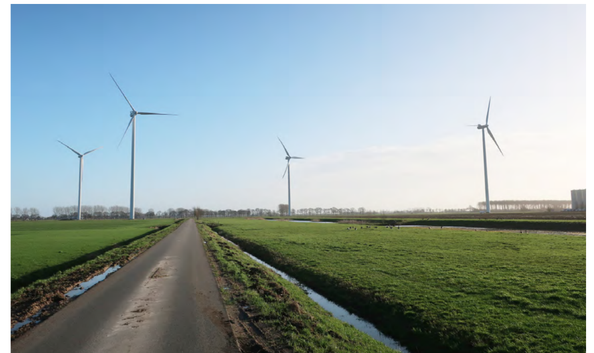
Windturbines in vlakopstelling in een open landschap
