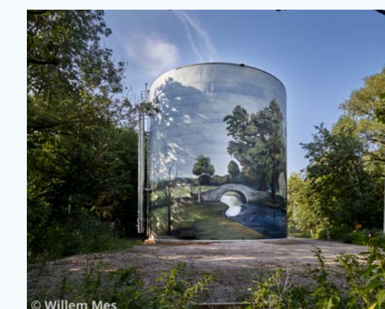
^ Warmtebuffertank Eneco Utrecht
