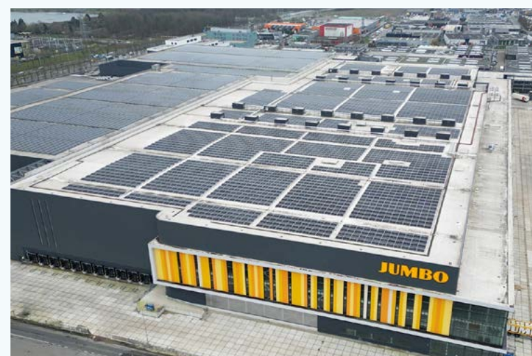
^ Opwek op dak van distributiecentrum Jumbo Nieuwegein
